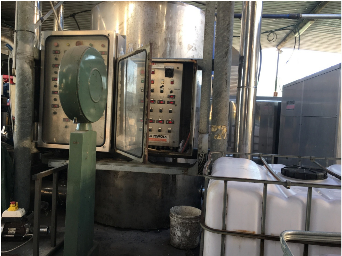
Figura 19 esempi di quadri di comando gestiti in modo scorretto
